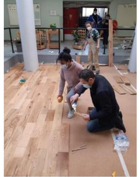
Avant de poser le parquet, on a fixé avec du ruban adhésif, sur le sol, deux sous-couches : 1 en aluminium et 1 en liège.
